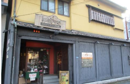
蔵を改修した店舗
