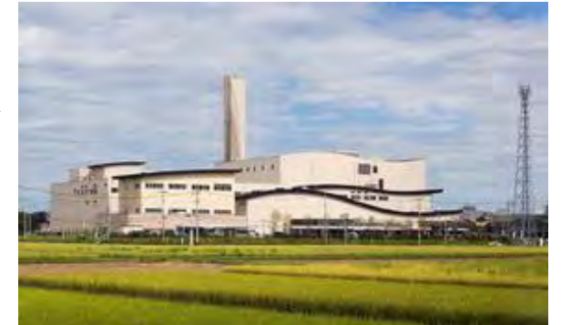
ふじみ野市 三芳町環境センター
