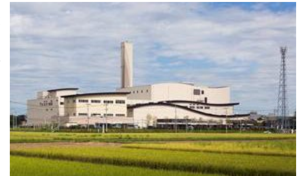
ふじみ野市 三芳町環境センター
