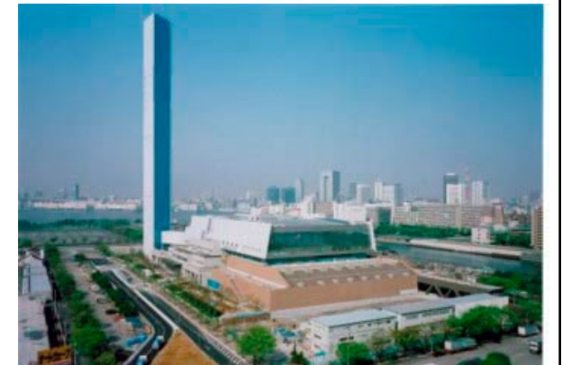
中央区清掃工場
