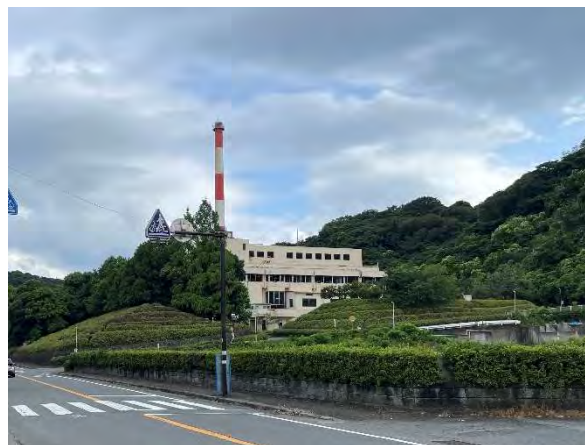
写真 現清掃プラント （新余熱利用施設整備エリア）
