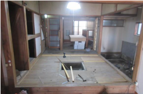
市街地にある空き家
