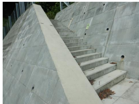
急傾斜地の整備
